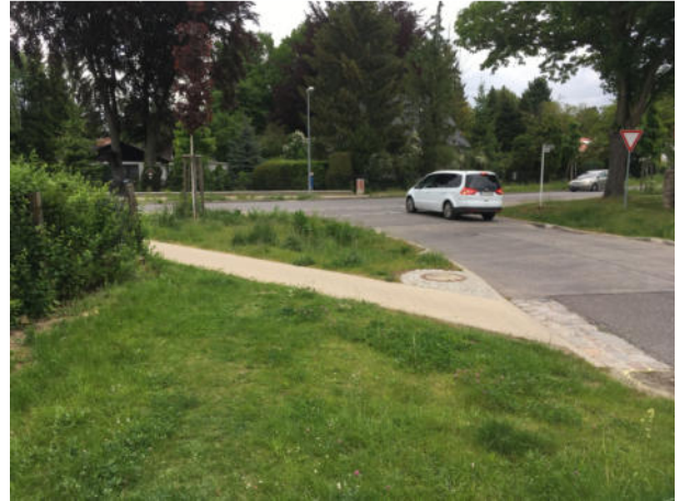
Bauende – Anschluss an den neuen Gehweg im Kieferndamm
