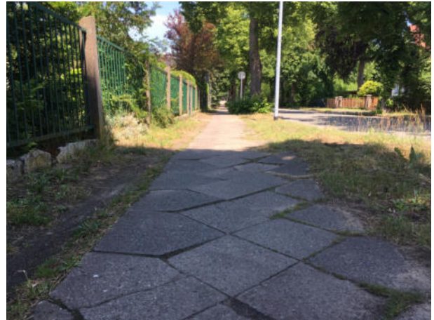
Verschobene Gehwegplatten
