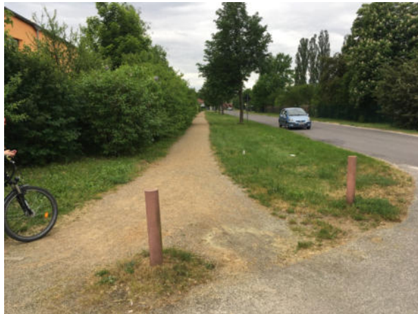
Gehweg aus wassergebundener Decke ab Kita (Einmündung Grätzsteig)
