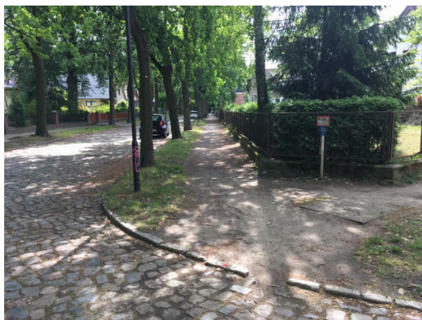
Bauanfang Einmündung Platanenstraße
