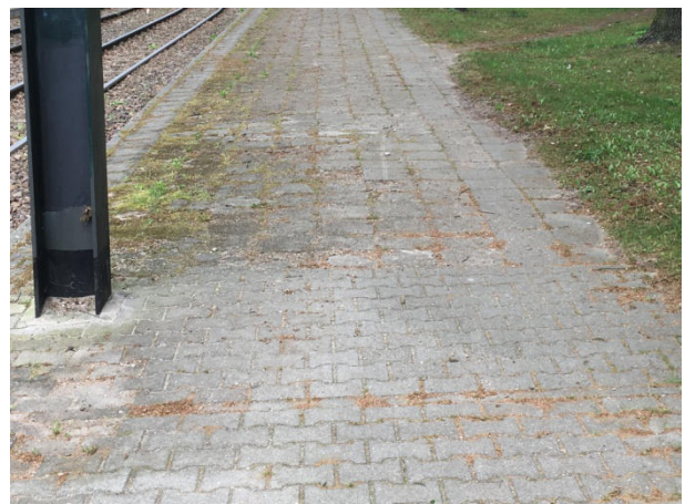
Übergang vom Bahnsteig (Zuständigkeit SRS) zum Gehweg der Gemeinde
