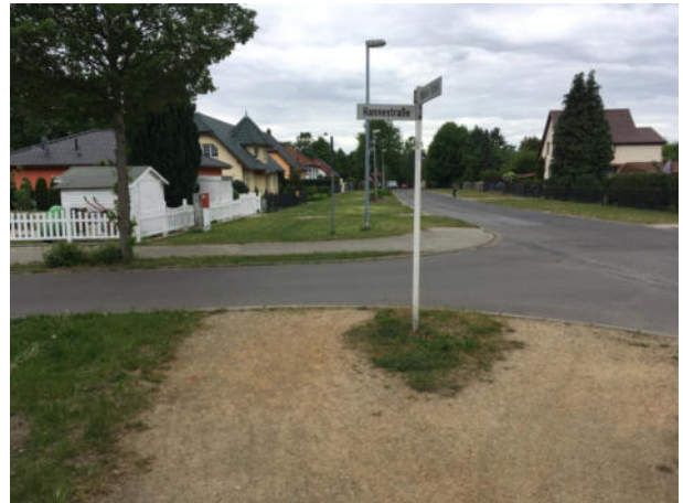
Ende des Gehweges an der Einmündung Hannestraße
