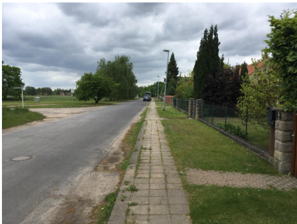
Gehweg zwischen Kantstr. und Bauende
