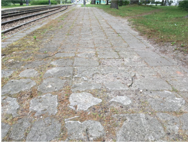
Poröse Gehwegplatten
