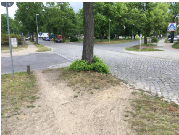
Knotenpunkt Berliner Str./Woltersdorfer Str.
